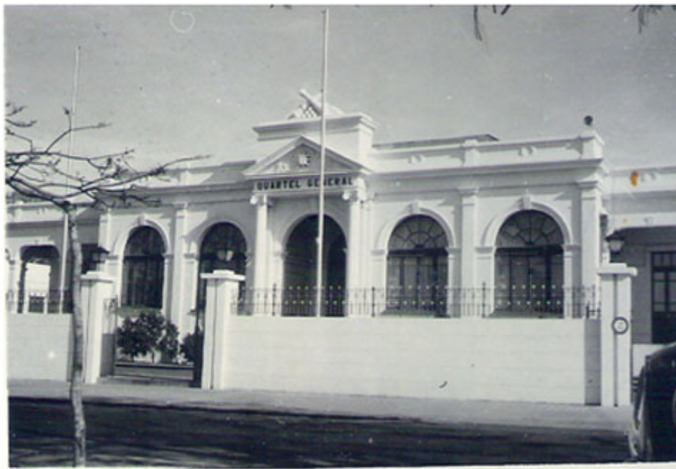
Fig.50 – Quartel General da RMMoçambique até 1965.
