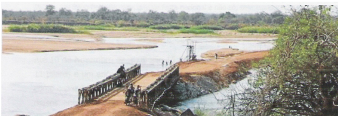
Fig. 57 – A ponte do Rovuma em construção
