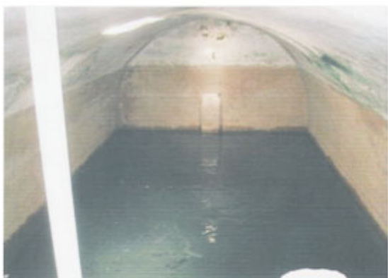
Figura 21 – Uma cisterna da fortaleza
