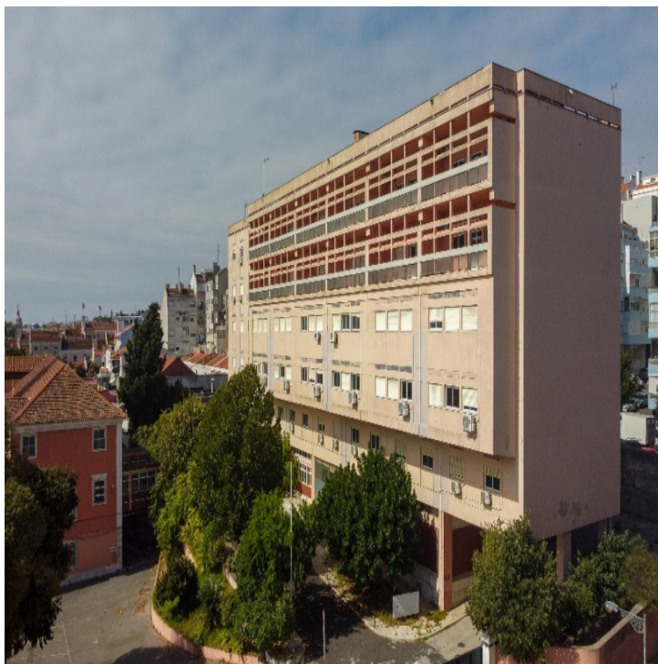
Figura 1 - Bloco Hospitalar actual do Hospital Militar de Belém.
